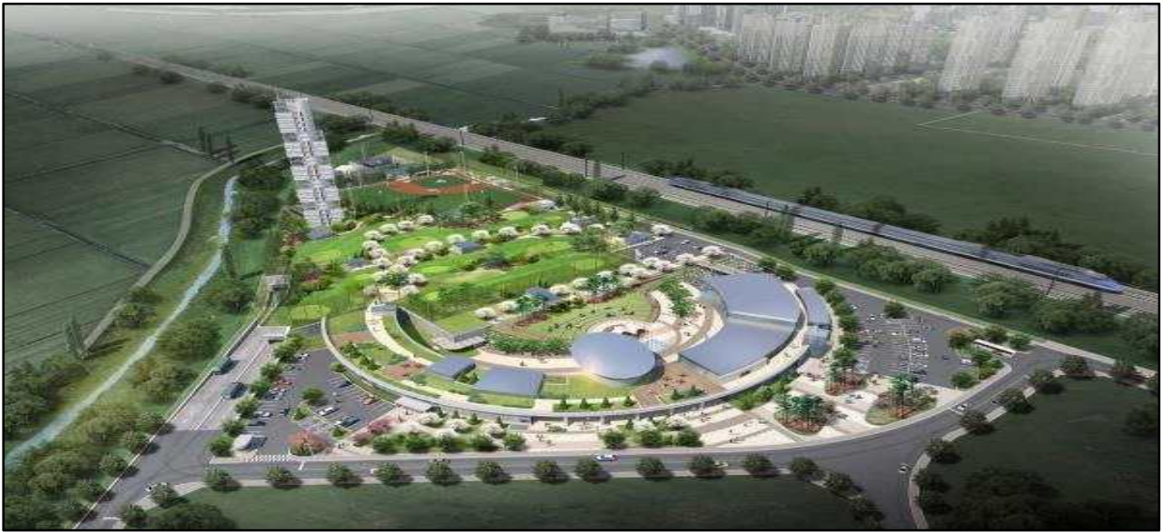
< 그림 2-5-11 > 가연성 폐기물 고형연료화(SRF) 시설(평택 에코센터)
