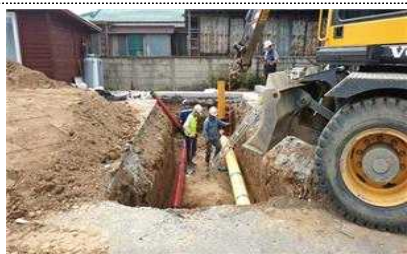
도시가스 배관망 설치
