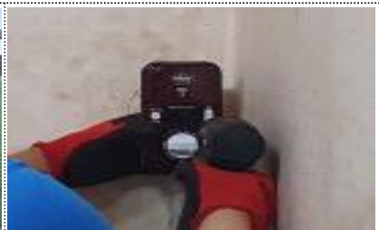
가스안전장치(타이머 콕) 설치
