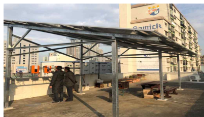
태양광 설치 지원
